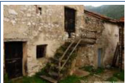
Foto5: abitato di Costa
